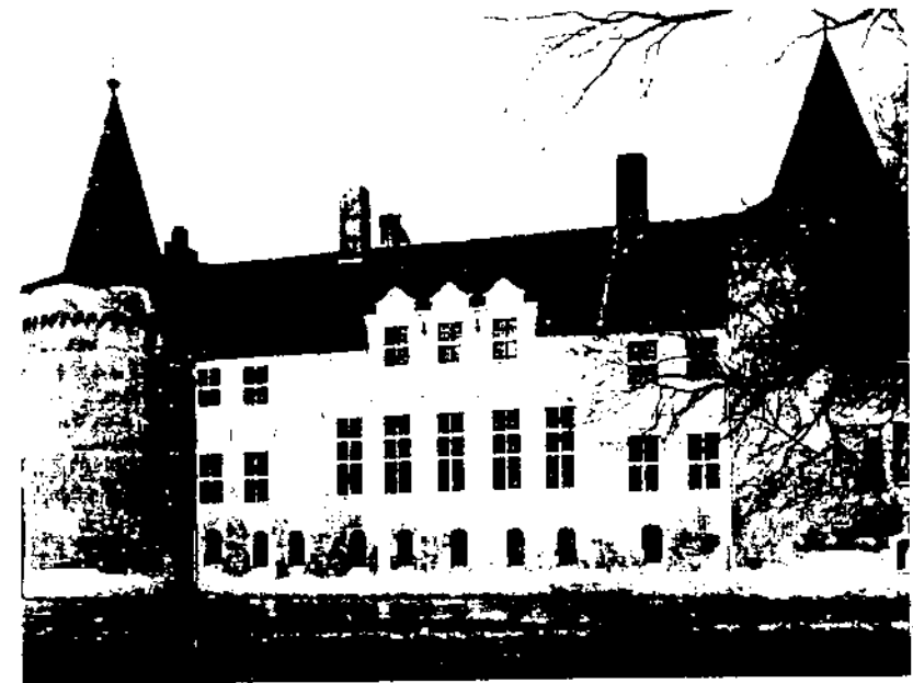
Achterzijde, vóór en na de restauratie (raadszaal)
