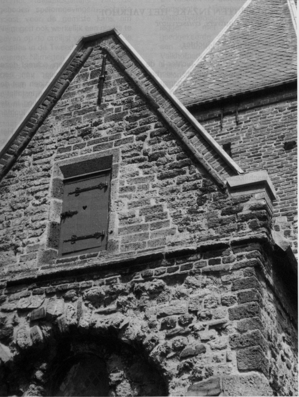
Bescherming topgevel kapel met 'schouderstukken (foto Fer Boshouwers)
